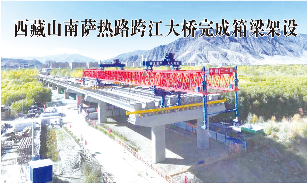
10月13日，横跨雅鲁藏布江山南段的西藏山南萨热路跨江大桥最后一片箱梁精准落位，该桥88片箱梁的预制与架设任务全部完成，为后续主桥段挂篮施工奠定了坚实基础。萨热路跨江大桥全长1457米，建成后将成为连接雅江两岸的重要交通枢纽。图为施工人员在架设萨热路跨江大桥的最后一片预制箱梁。
