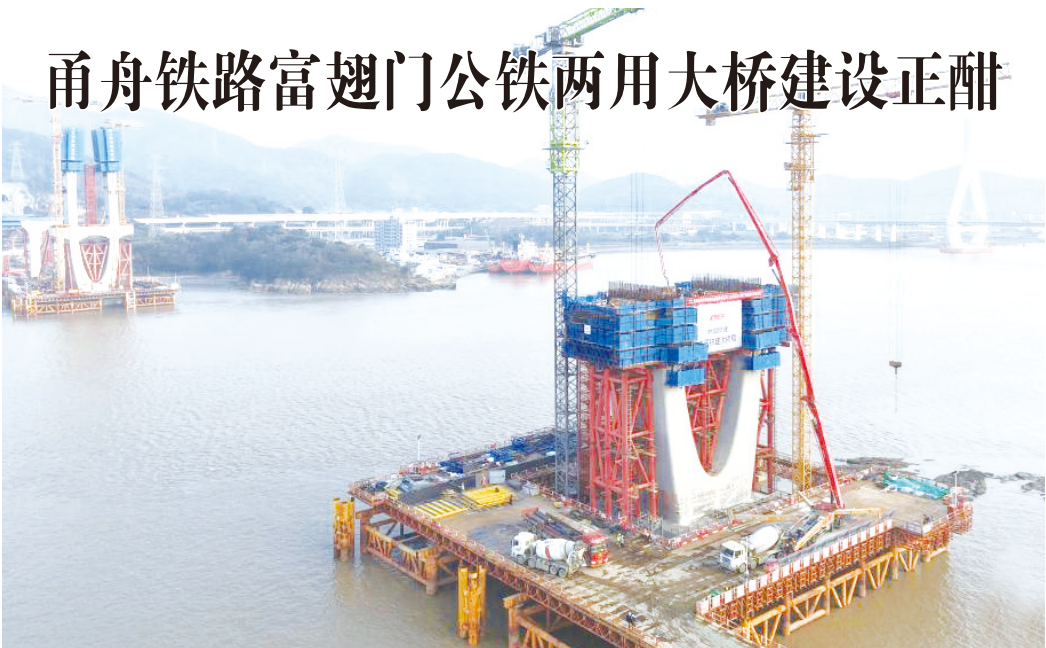
12 月 1 日，由中国铁建大桥局承建的甬舟铁路富翅门公铁两用大桥 20 号主墩下横梁顺利完成浇筑，标志着大桥正式转入中塔柱施工阶段。富翅门公铁两用大桥连接舟山本岛与富翅岛，是甬舟铁路的控制性工程之一。大桥全长约 1726 米，主跨达 388 米，采用双线铁路、6 车道高速公路同层布置的形式。图为拍摄的甬舟铁路富翅门公铁两用大桥 20 号主墩下横梁浇筑现场（无人机照片）。（黄宗冶 / 摄）
