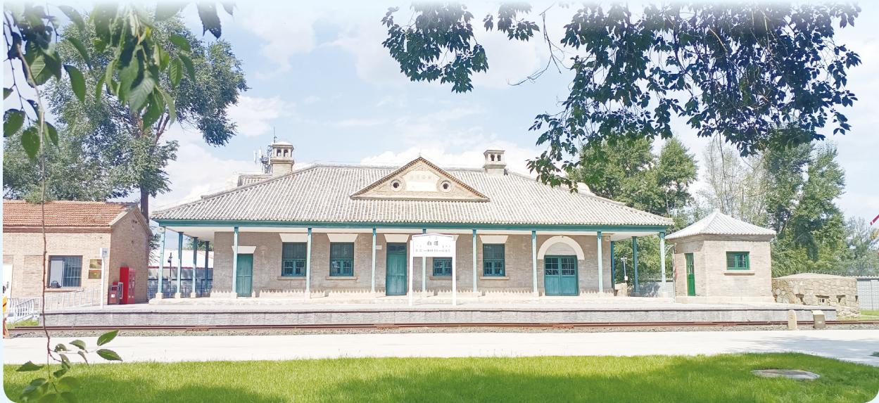
▲修缮后的白塔火车站旧址。
