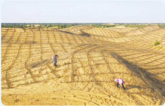
▲工人在杭锦旗境内的库布其沙漠里铺设沙障。
