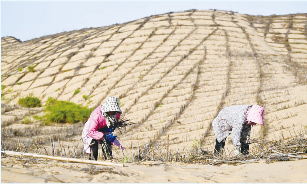
▲工人在杭锦旗境内的库布其沙漠里铺设沙障。
