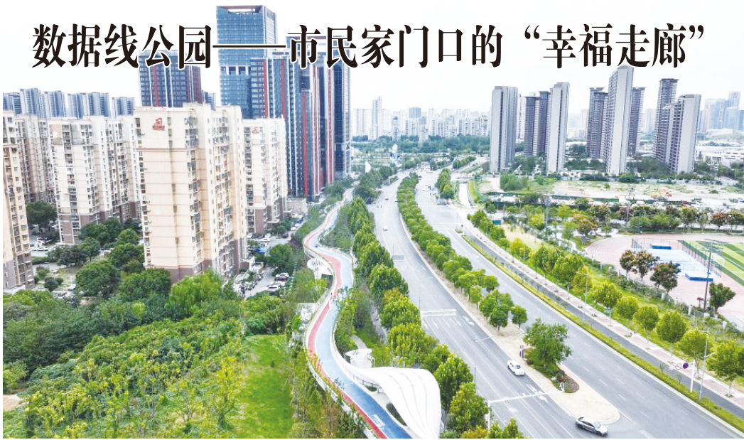
位于南京市雨花台区的数据线公园，是江苏省首座高线公园。这座全长约 8 公里的线性公园，以红蓝交织的步道为纽带串联起社区、医院、商圈等，成为市民家门口的“幸福走廊”。图为市民行走在南京市雨花台区的数据线公园“空中廊桥”（无人机照片）。
